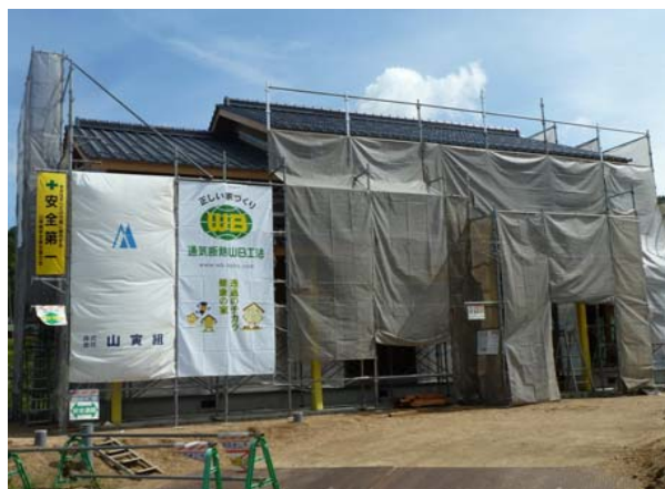
峰山町のI邸です 屋根の瓦葺き工事中です
