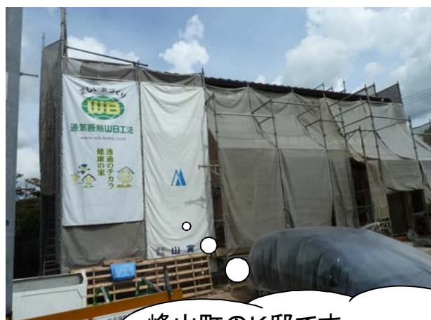
峰山町のK邸です。 外壁の塗装工事中です、
